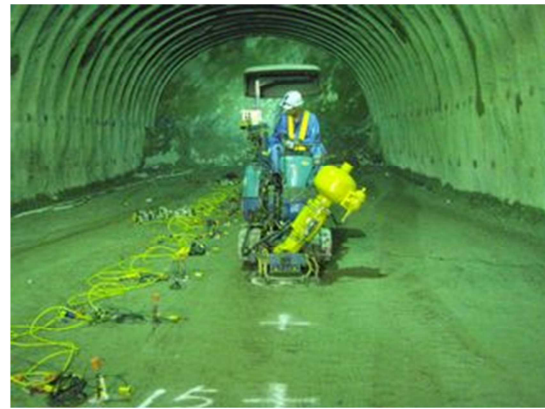
写真-1 S波用油圧インパクトによる左右打撃状況 12)
