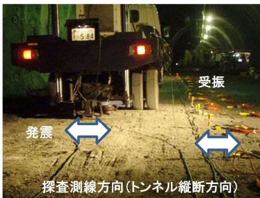
(c)S波発震状況（測線方向）
