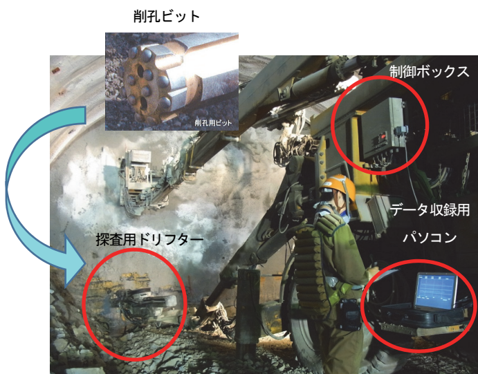
写真-1 ノンコア削孔切羽前方探査施工状況
