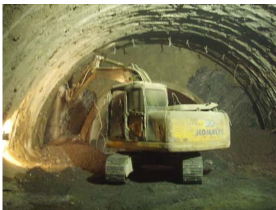
写真-2 TBM断面からCOMトンネルへの切掛け
