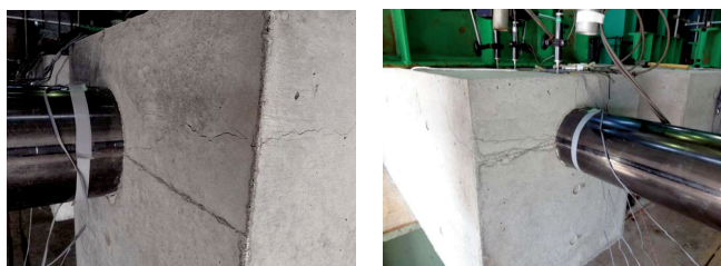
写真 3 Case1 ひびわれ状況写真
