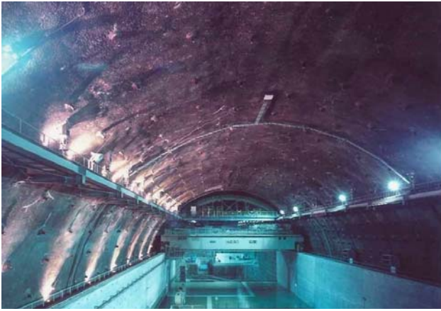
図-1 地下発電所天井部（神流川発電所）
