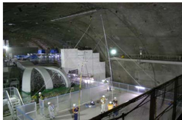
図-11 延長ジグを用いた高所箇所の検査状況（天井部）
