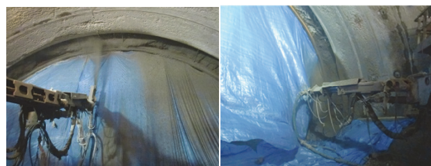
写真-1 試験施工の状況
