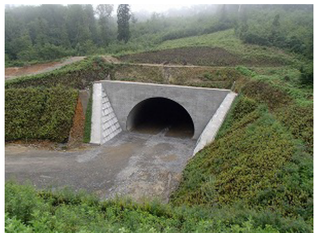
写真-1 田老第6トンネル
