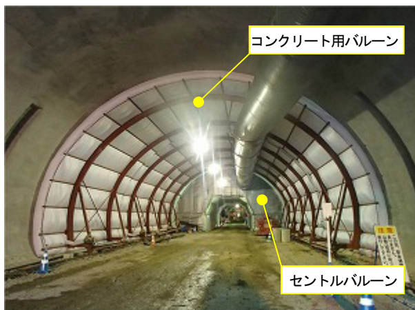
写真-2 バルーン養生状況
