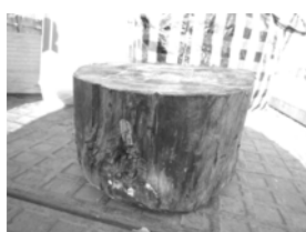
木製電柱下部
