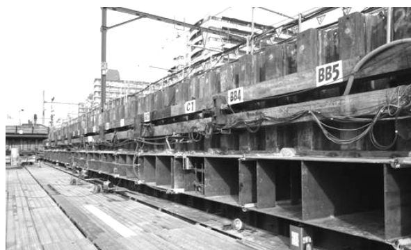
図-21 上床版エレメントの掘進完了状況
