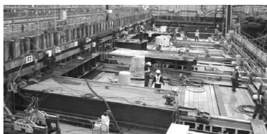
図-16 上床版エレメント掘進時の発進立坑の状況
