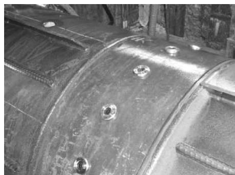
写真-4 パイプルーフ鋼管接合状況
