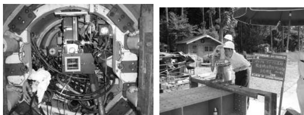
写真-2 計測管理システム実機試験
