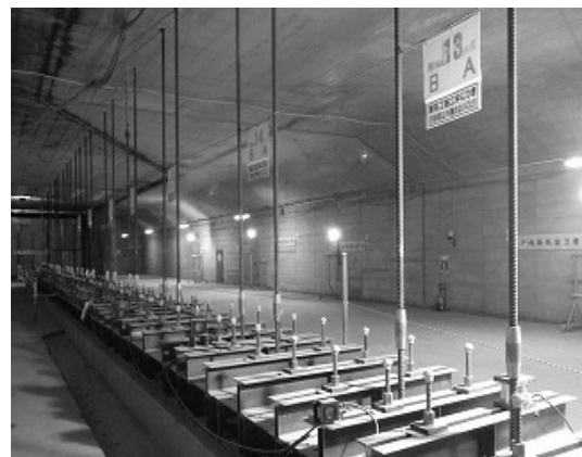
写真-1 図-6 桙部の中床版吊り施工状況
