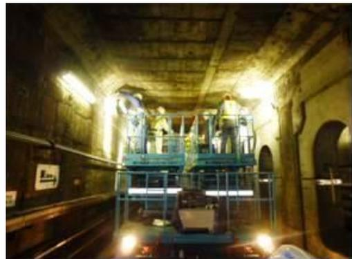
写真-2 近接目視、打音検査
