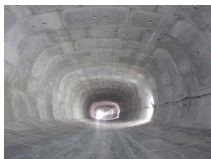
写真-17 トンネル坑内完成
