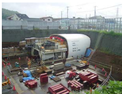
写真-11 上り線シールド地上発進
