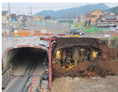
写真-14 下り線シールド地上到達
