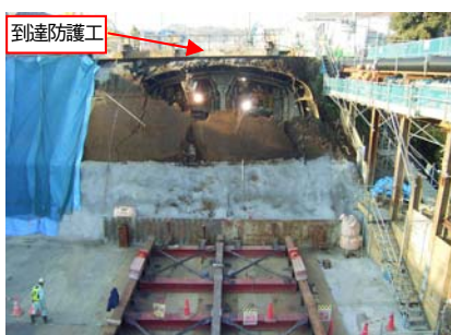
写真-13 上り線シールド地上到達
