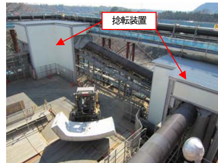
写真-16 連続バルコン捻転装置
