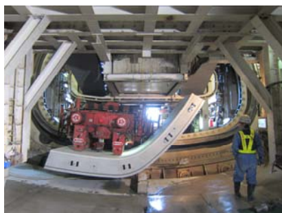
写真-5 セグメント組立状況
