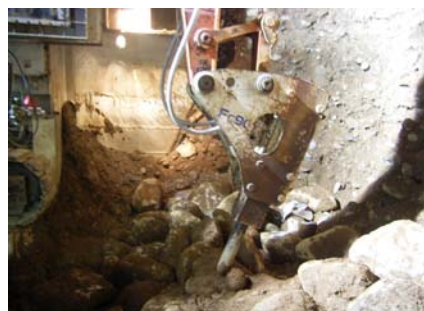
写真-9 ブレイカーによる礫破碎
