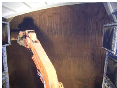
写真-6 切羽地山状況
