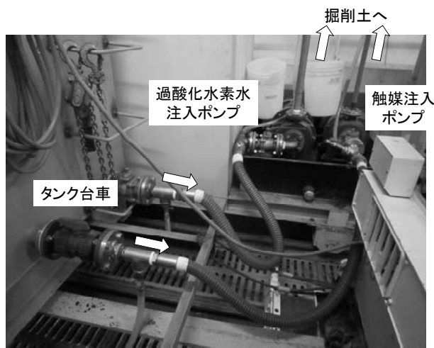
写真-3 タンク台車と注入ポンプの接続状況
