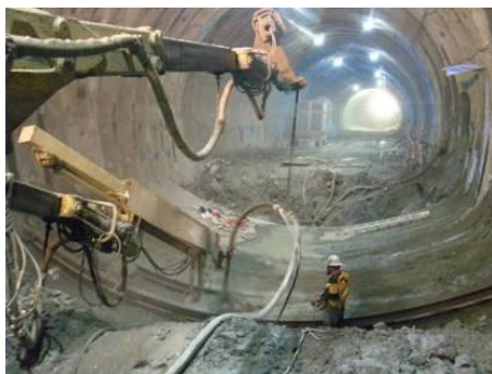
写真-3 断面閉合状況
