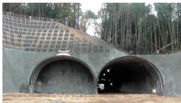
写真-3 起点側坑口全景
