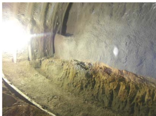
写真-1 インバート吹付け実施状況
