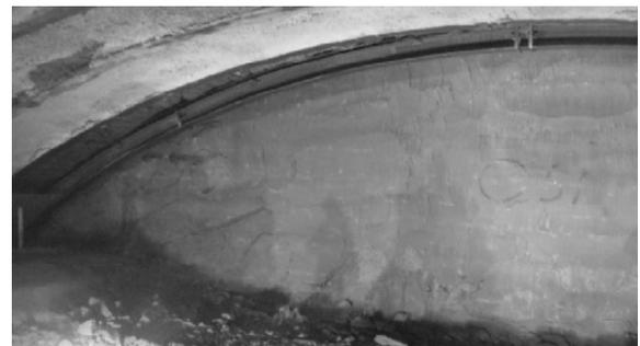
写真-1 上半掘削切羽面
