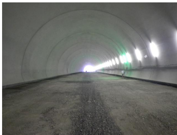
写真-15 覆工コンクリート完了状況
