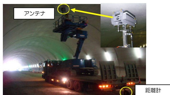
写真-14 空洞探查实施状况
