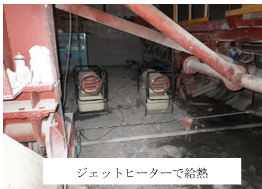
写真-10 ジェットヒーターによる給熱養生（足元）
