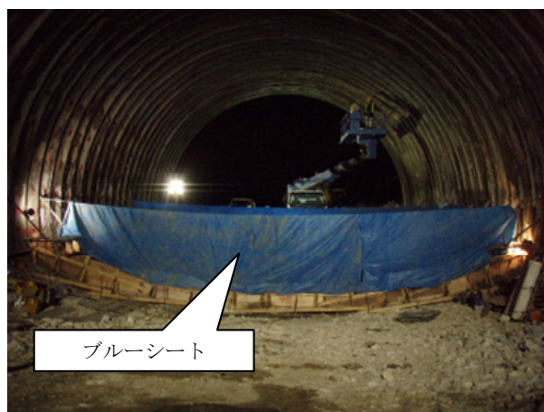
写真-12 シート養生状況
