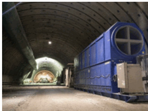
写真-1 坑内作業状況
