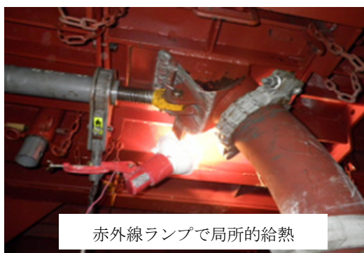
写真-11 赤外線ランプによる給熱養生（吹上げ口）
