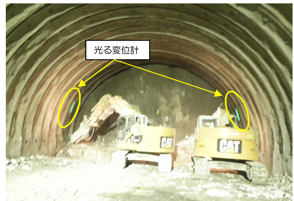
写真-2 切羽近傍における設置状況
