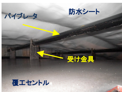
写真-6 長尺パイプレータ設置状況（セントル内部）
