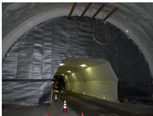
写真-9 セントルバルーン設置状況
