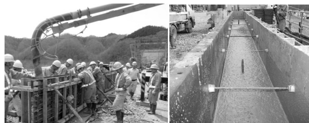
写真-2 模擬型枠を用いた打設試験状況
