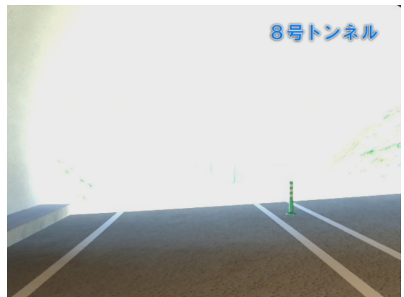
図-8 トンネル出口付近（最明時）
