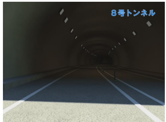
図-6 トンネル入口付近（最暗時）
