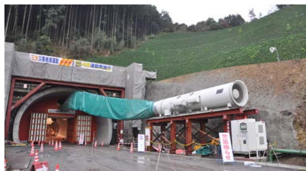
写真-3 坑口部の状況
