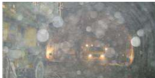
写真-2 坑内写真（フラッシュ有り）
