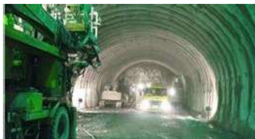
写真-1 坑内写真（フラッシュ無し）
