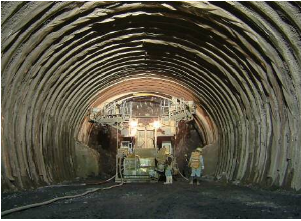
写真-3 大型機械による切羽作業
