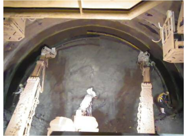
写真-4 鋼製支保工をセットした状態での鏡吹付け状況
