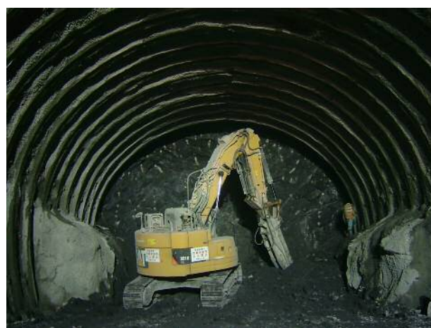
写真-2 曲面切羽の施工
