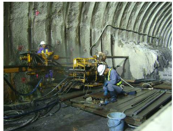
写真-1 急速コアサンプリング水抜きシステム
