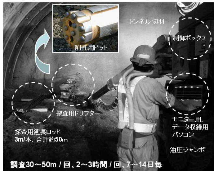
写真-1 切羽での探査状況
