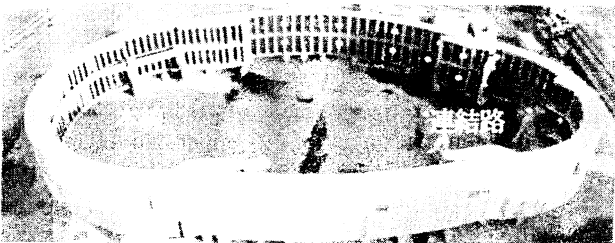
写真-14 鋼殻セグメント（切開き区間）
