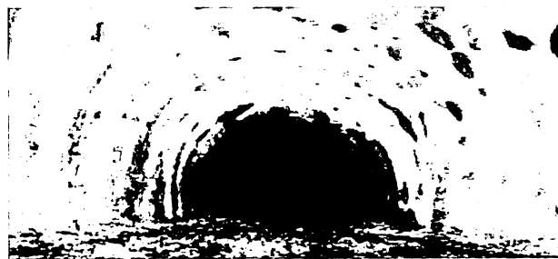
図-2 三次元レーザースキャナで測定したトンネル坑内壁面の点群データ
