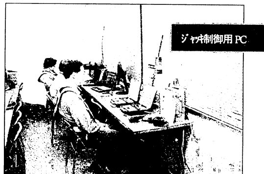
写真-2 中央制御室
