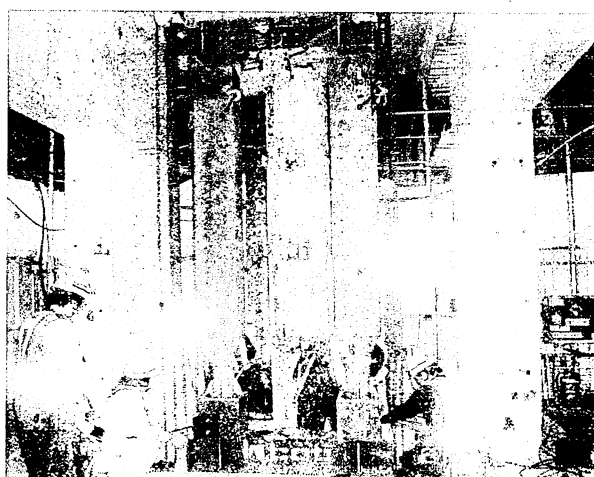
写真1 施工写真(左:A線地下2階仮受け工(RC 構造)、右:B線地下2階受替え工(SRC 構造))
