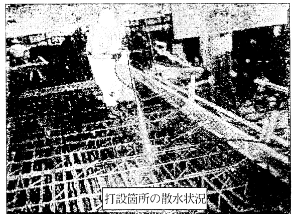
写真-1 生コンクリート圧送時の温度上昇防止対策実施状況
