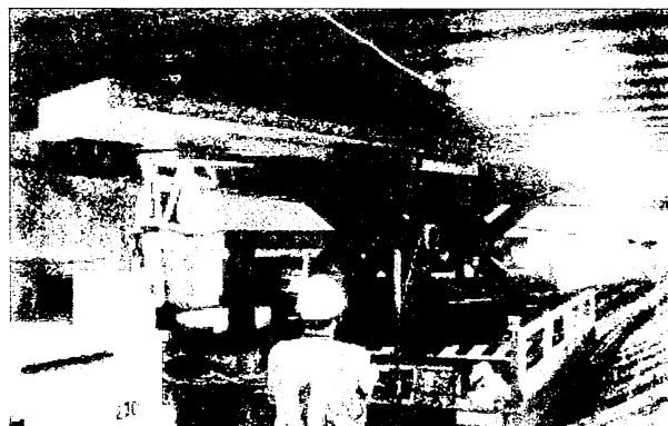
写真-4 合成床版設置状況
