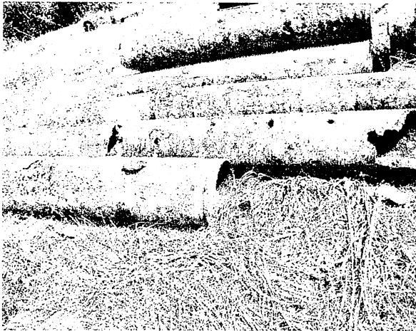
写真-1 直埋方式の送泥管の老朽化による劣化の事例
