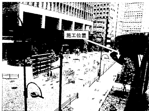
写真-1 施工位置写真
