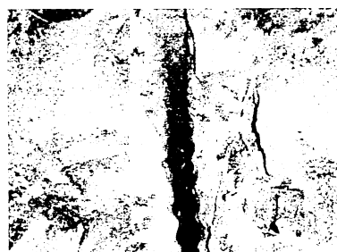
写真-2 連続孔による自由面の形成状況
