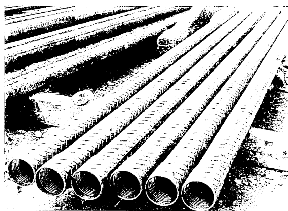
写真-1 縞付き鋼管による切羽補強工部材
