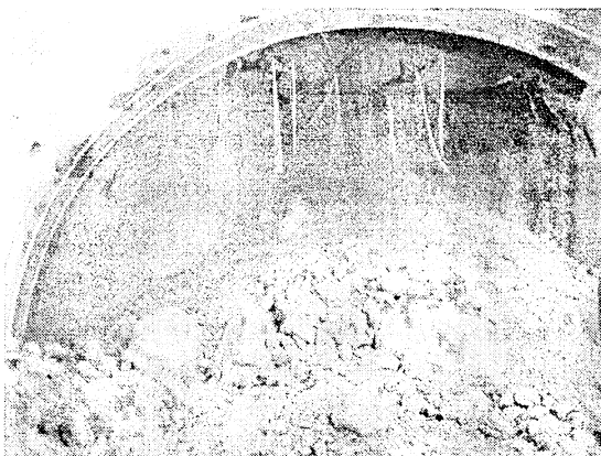
写真-1 切羽剥落状況
