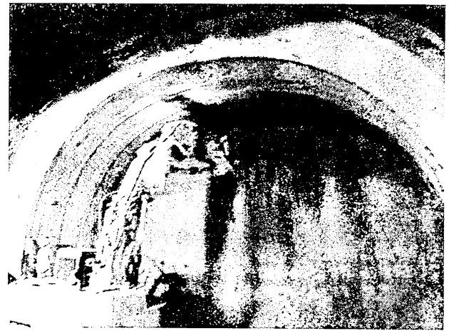
写真-3 掘削時流砂現象発生状況 (TD519m地点)
