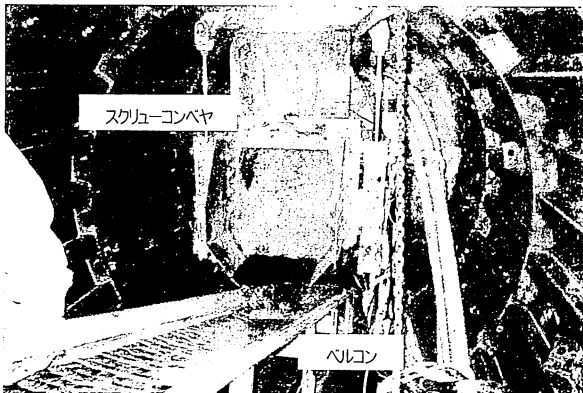
写真-3 掘削土排土状況
