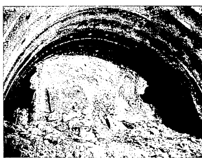
写真-2 軟質地山の崩壊例
