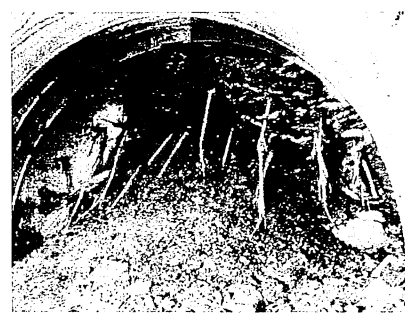
写真-3 層状地山の崩壊例
