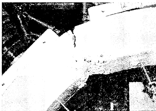
写真-6 圧さ発生状況 (ケース1: 無筋, 地盤反力あり)
