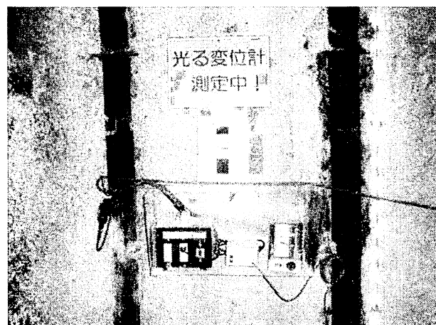
(a) 電源の取り付け
