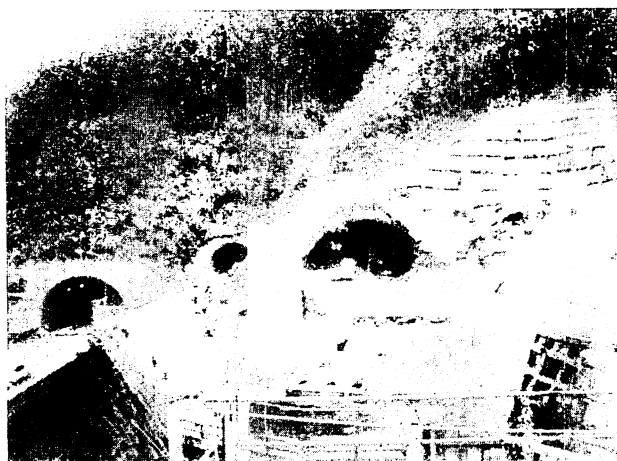
図-9 本坑貫通後現場写真
