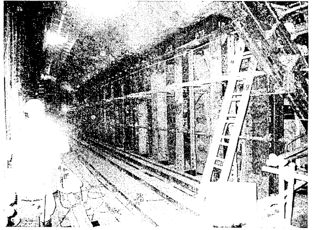
写真-4 側壁支保工設置完了(シールド内から撮影)
