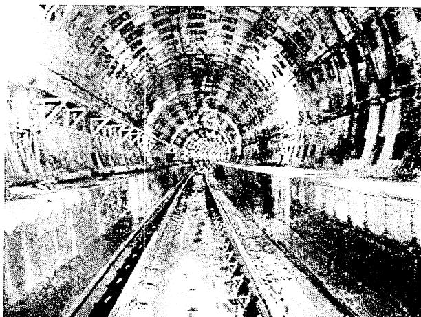
写真-13 二次覆工施工前
