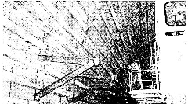
写真-11 軽量パネルの改良前：仮設梁間隔300mm
