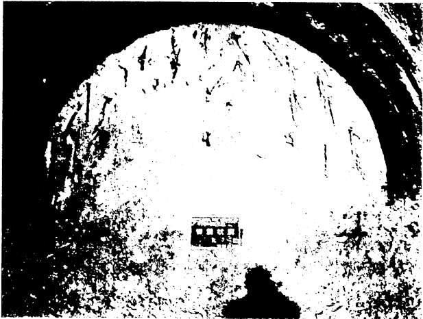
写真-1 埋金断層部切羽状況写真（梶原工区15k362m付近）
