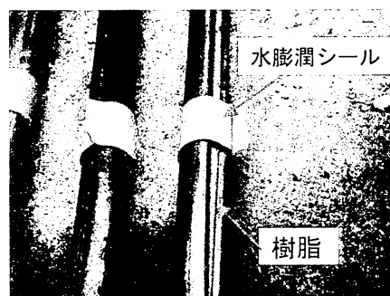
写真-8 パッカー部の改良状況
