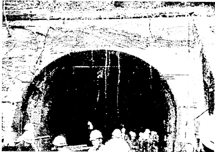
写真-2 東山トンネルの地震被害 4)
