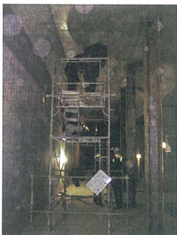
写真-1 近接目視によるひび割れ調査状況
