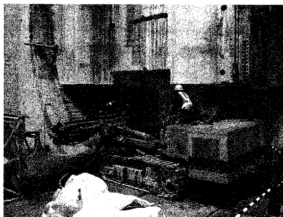
写真-3 フェイスボルト打設
