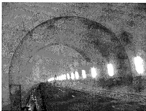
写真-2 仕上り状況
