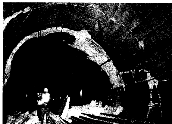
図-1 新潟県中越地震による地震被害状況
