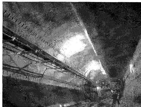
写真-2 RCライナーの施工完了状況
